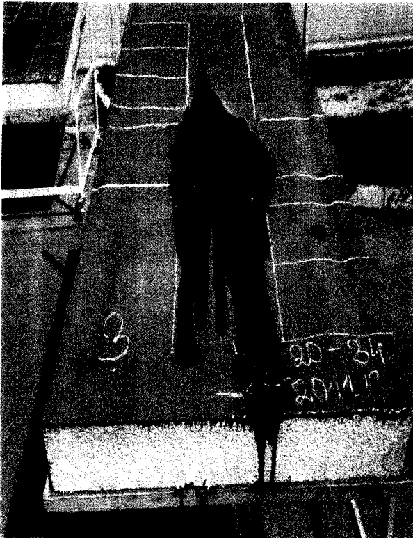
Stogo konstrukcijos fragmento vaizdas po bandymo.
